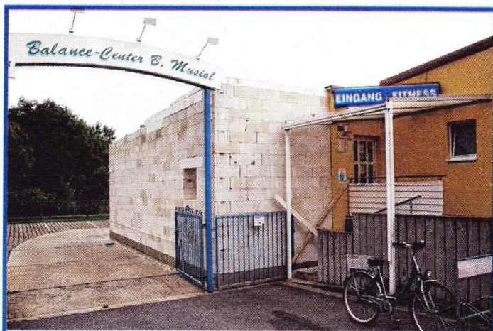
Der Rohbau des neuen Empfangsbereichs steht bereits. Foto: cs
